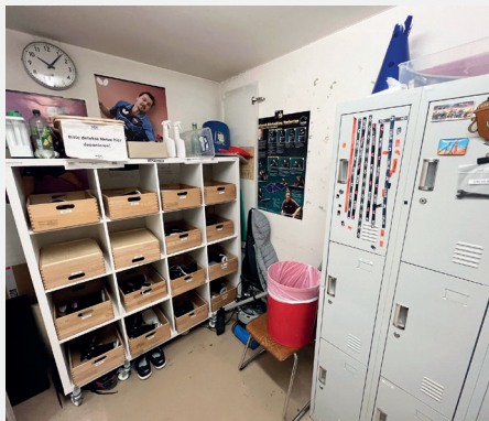
Kurz vor den Malerarbeiten
